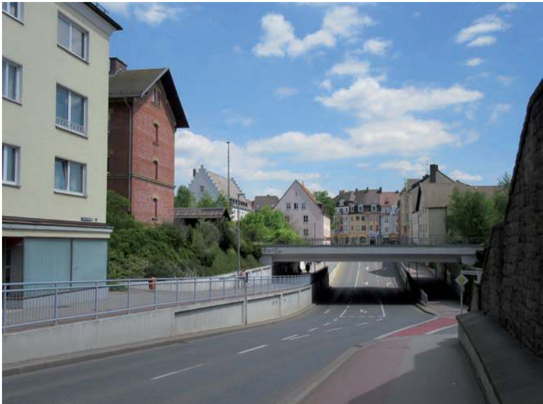
24 Frauenrichter Straße in Richtung Osten mit Bahnunterführung
