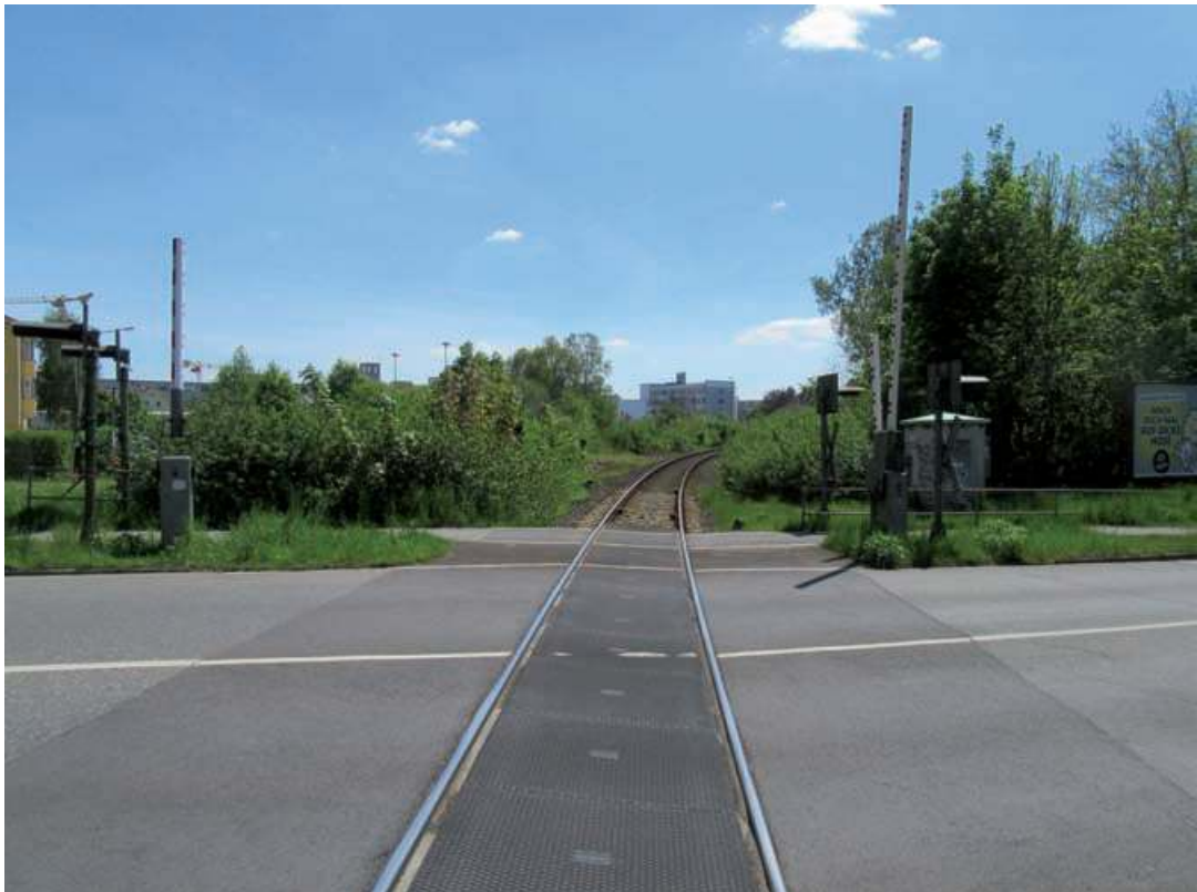
16 Bahnlinie - Übergang „Sintzelstraße“ in Richtung Südwesten
