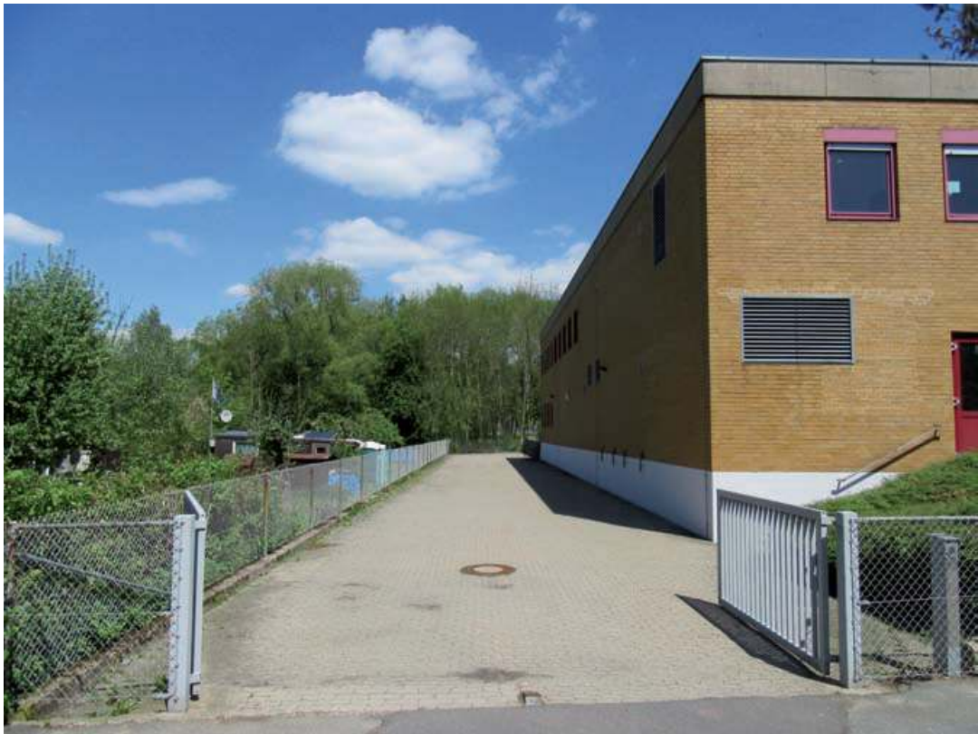
07 Telekomgebäude mit beginnenden Kleingartenanlagen
